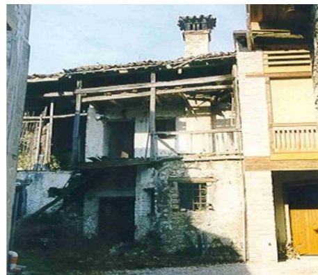
Facciata edificio su mappale 409 (primi anni '90)
